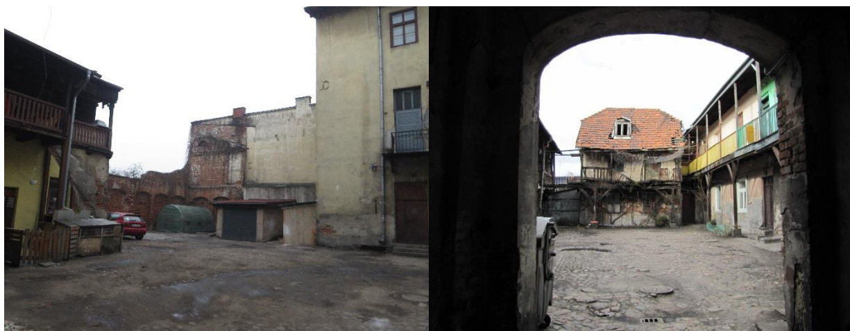
Fotografia 1. Budynki w obszarze rewitalizacji – przykłady, ul. 3 Maja.
