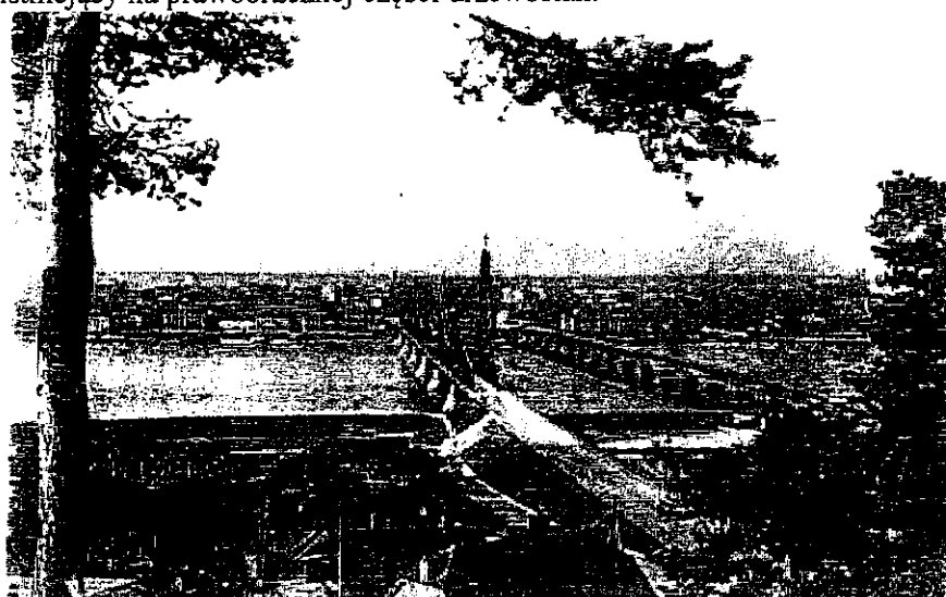
Rys. 13. Panorama miasta Włocławek od strony Szpetala. Na pierwszym planie od lewej most drogowy z lat 1935-1937 (obecnie most im. Marszałka Rydza-Śmigłego), obok stary most z 1915/1916 r., w głębi Katedra i Pałac Biskupi, fot. n.n., ok. 1938 r. (źródło: ze zbiorów MZDiK we Włocławku)
