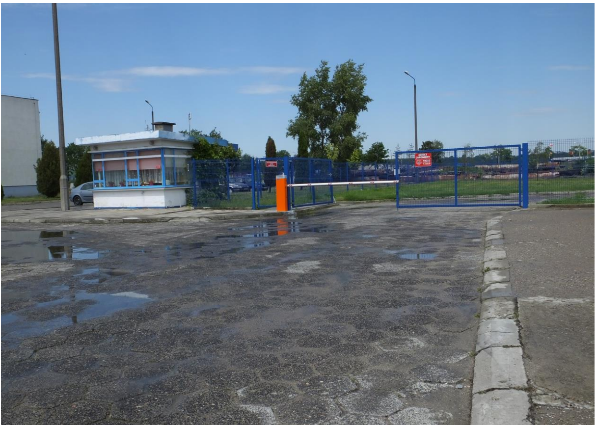
Fotografia 2. Tereny zaplecza infrastrukturalnego Stopnia Wodnego we Włocławku
