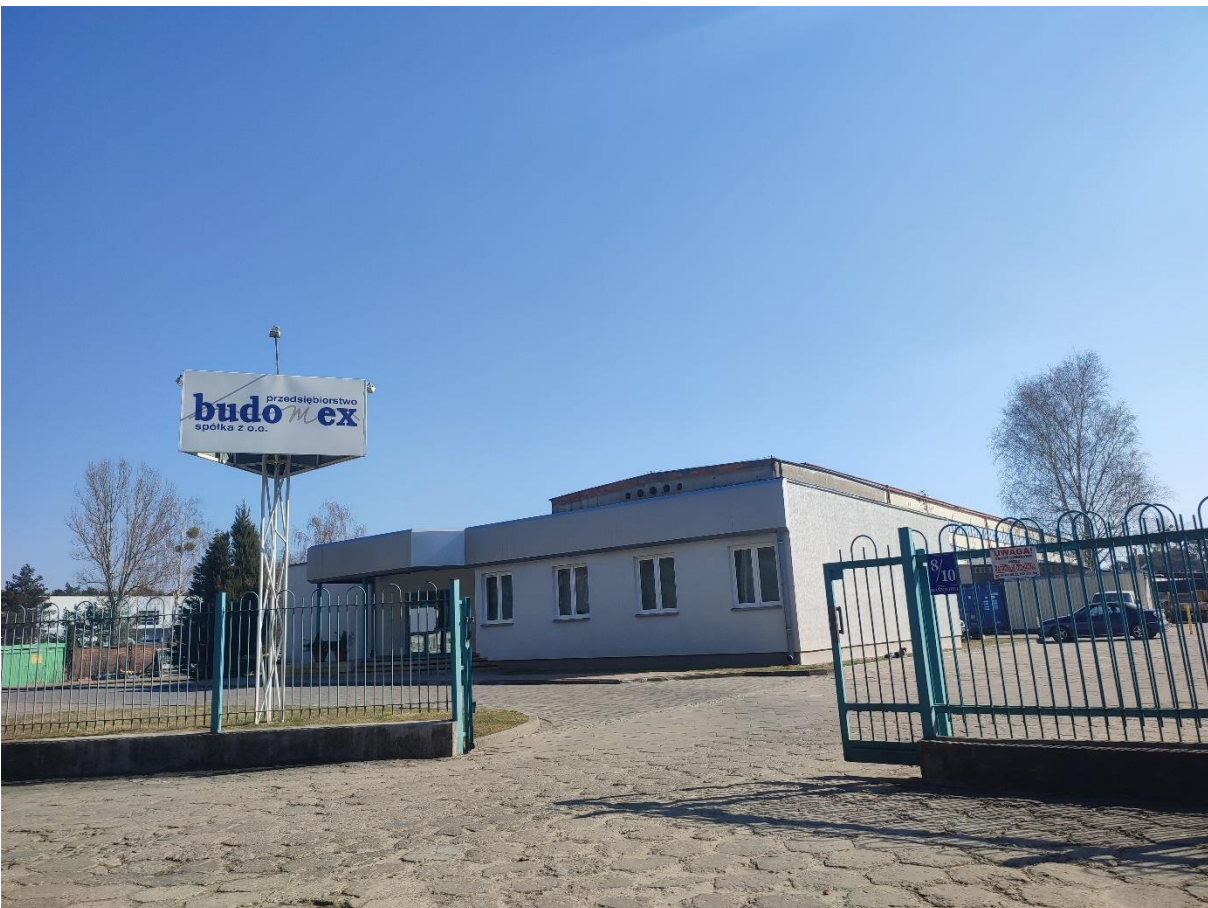
Fotografia 6. Widok na obiekty przedsiębiorstwa Budomex Sp. z o.o. w południowo-zachodniej części obszaru
