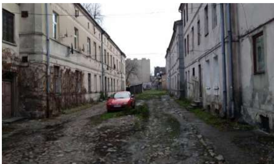
Rysunek 43. Włocławek, Śródmieście ul. 3Maja. Infrastruktura pomiędzy budynkami
